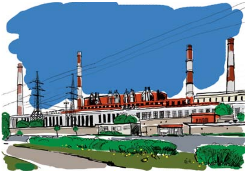
Первомайская ТЭС-14. Санкт-Петербург
